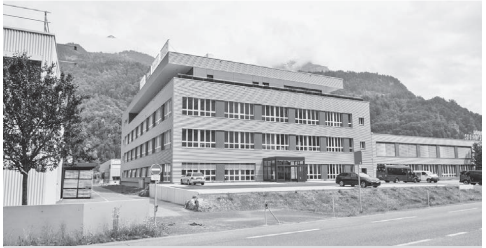
Das neue Gewerbehaus am nördlichen Eingang von Netstal. (Foto: Christian Bosshard)
