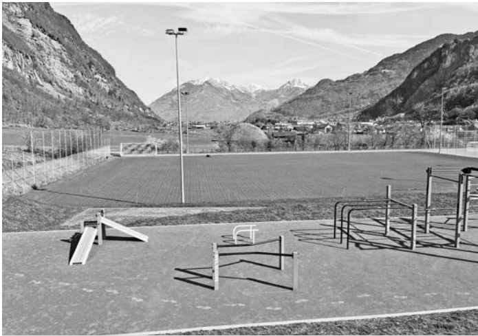
Gesamtübersicht des neu sanierten Sportplatzes. (Fotos: Hans Speck)
