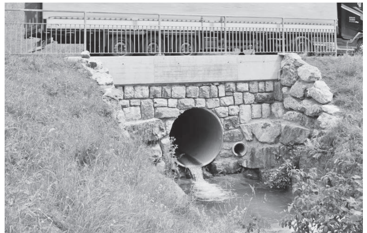
Die neue Schlattbachbrücke. (Fotos: Christian Bosshard)
