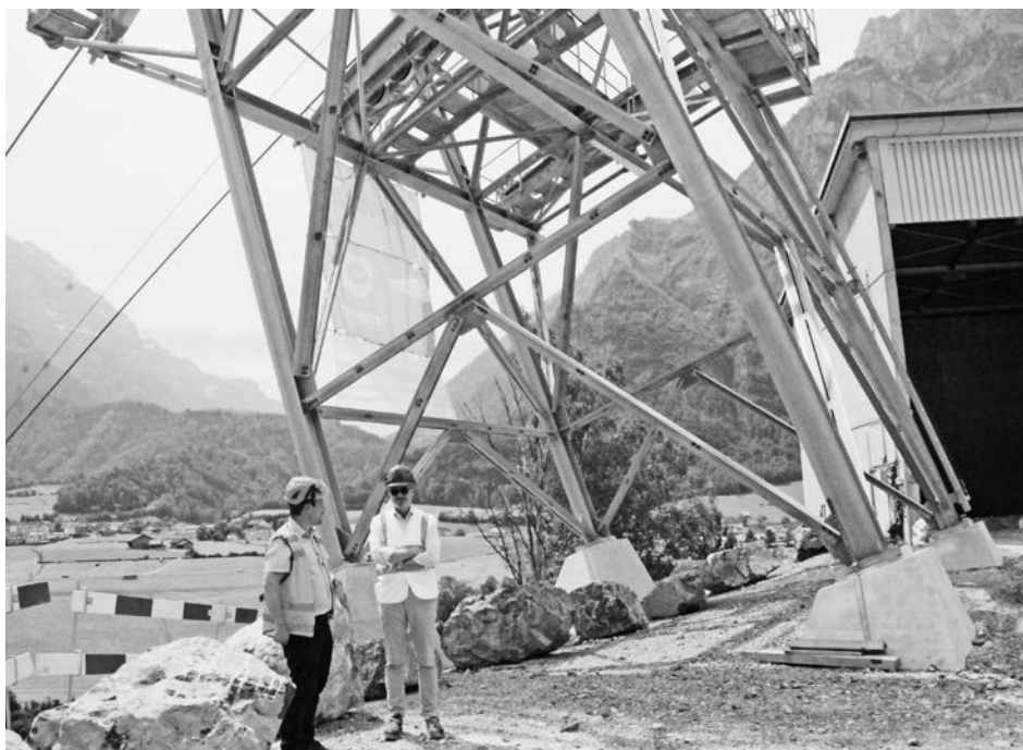
Die imposante Höhe der Stütze 2.
