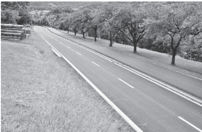
Die erneuerte Strasse Richtung Langgüetli.
