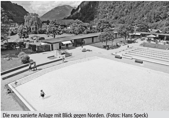
Die neu sanierte Anlage mit Blick gegen Norden. (Fotos: Hans Speck)
