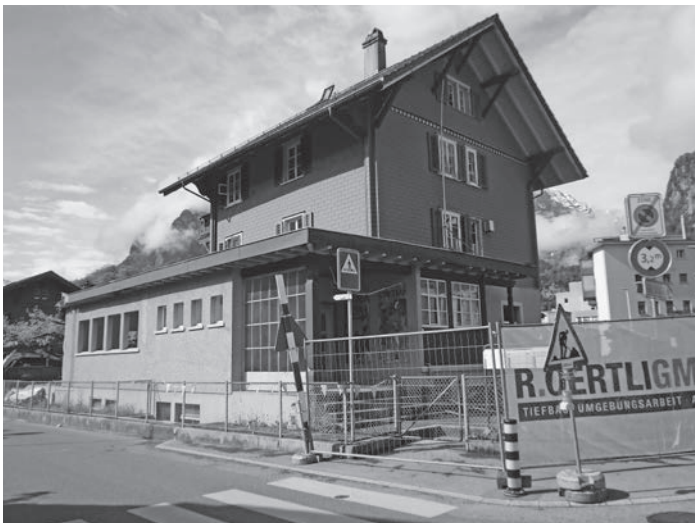
Der 1925 an das Wohnhaus von Seidendrucker Johann Schellenbaum erbaute Kindergartentrakt an der Ennetbachstrasse kurz vor dem Abbruch. (Foto: Jakob Kubli)
