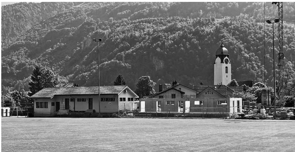
Die Klubhütte (links) und das im Rohbau befindliche Garderoben-Gebäude.
