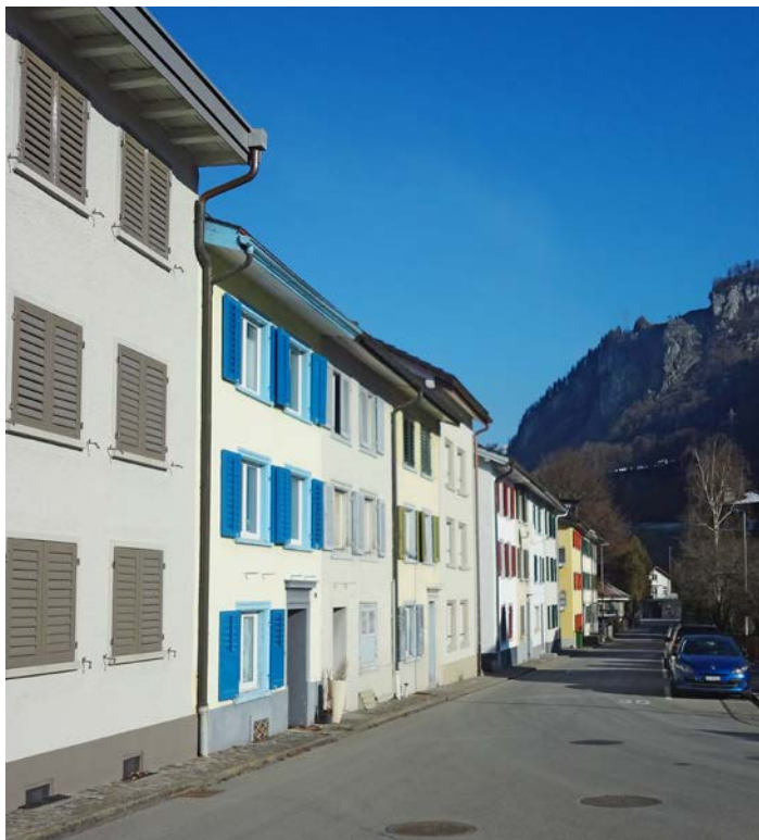
Die Häuserzeile mit den bunten Fassaden an der Ennetbachstrasse bildete bis in die Zwanzigerjahre auf der Ostseite die Dorfgrenze. (Foto: Jakob Kubli)
