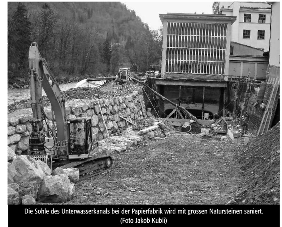
Die Sohle des Unterwasserkanals bei der Papierfabrik wird mit grossen Natursteinen saniert. (Foto Jakob Kubli)
