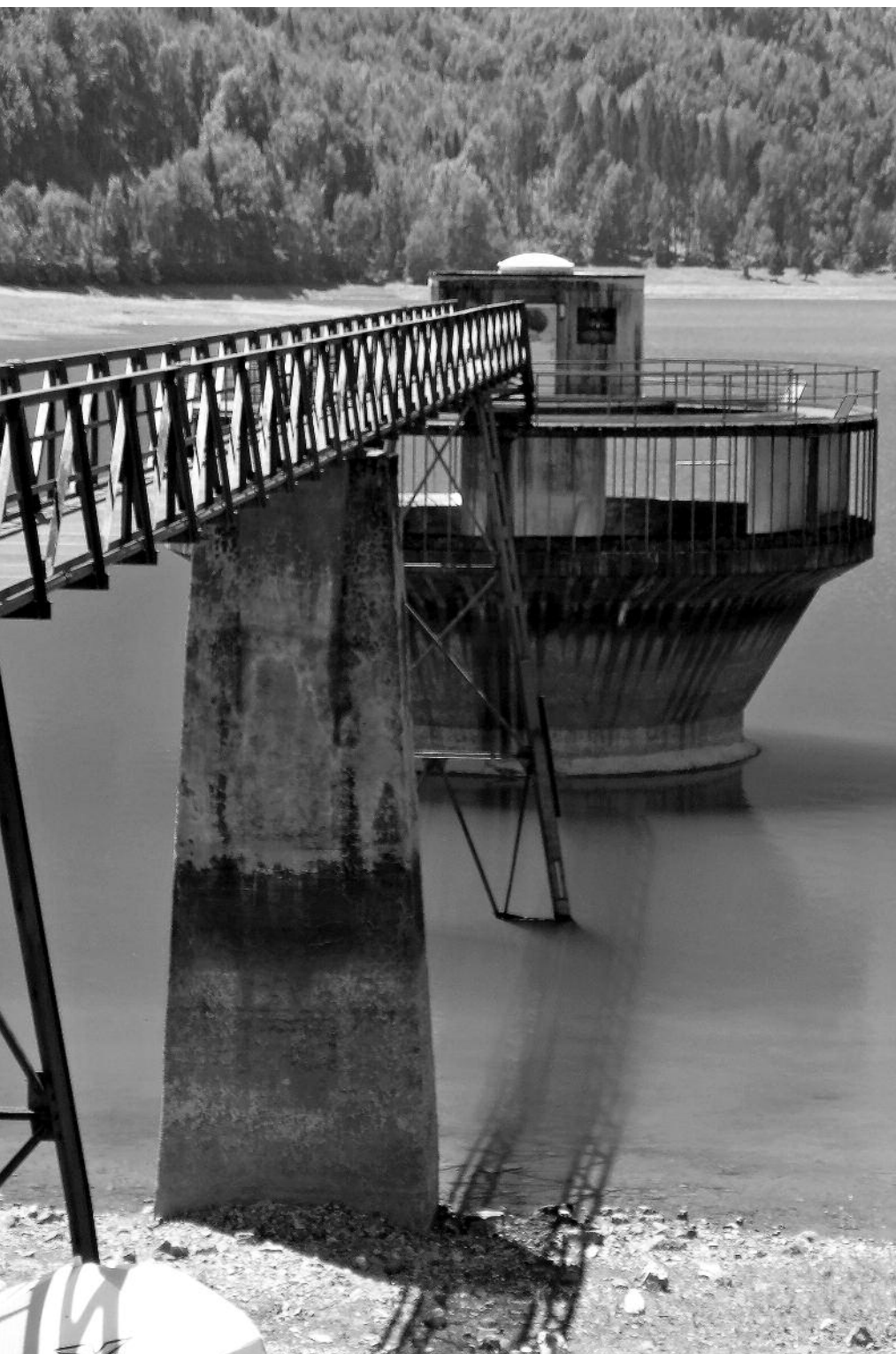
Der Klöntaler Überlauffturm beim «Rhodannenberg». (Foto: Jakob Kubli)
