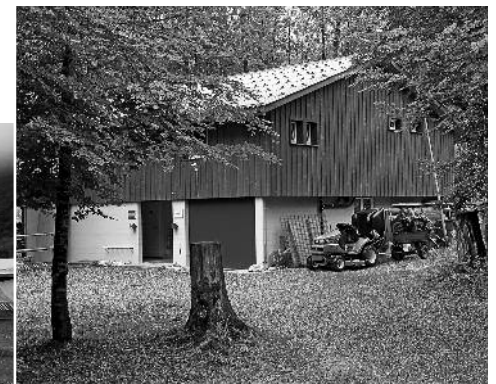
Das südlich gelegene Nebengebäude mit der WC- und Duschanlage konnte bereits Ende April 2013 in Betrieb genommen werden. (Fotos: Jakob Kubli)
