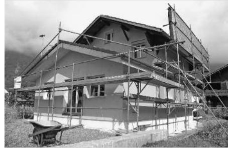
Derzeit zielt noch ein Bagerüst die Fassade an der Mattstrasse 9. (Foto: Jakob Heer)
