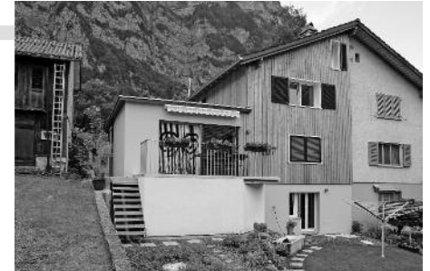
Hauserweiterung auf der Südwestseite samt Balkon.
