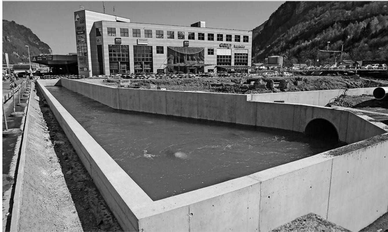
Bevor der Dorfbach dosiert unterirdisch den Wiggispark durchfliesst, wird das Wasser im Ausgleichsbecken gesammelt.
