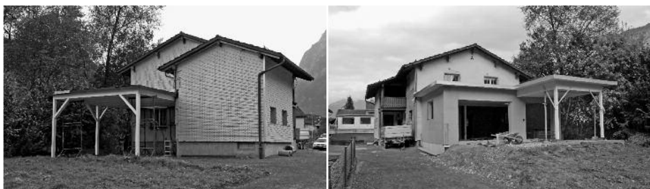
Der Hausumbau am Casinoweg ist in vollem Gange. (Bild Christian Bosshard)
