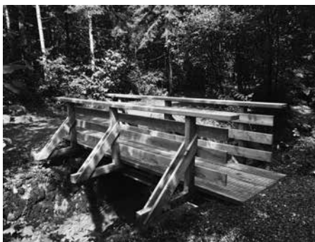
Die vom Zivilschutz Glarnerland erbaute neue Holzbrücke.
