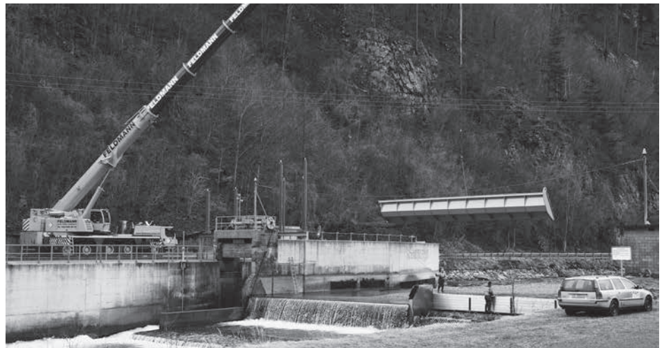
Mit einem Pneukran wird die neue Stau-Klappe im Rollengut-Wehr eingesetzt.
