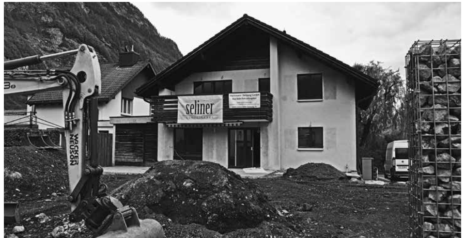
Die Erneuerungsarbeiten in Haus und Garten sind bald einmal abgeschlossen. (Foto: Christian Bosshard)
