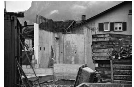
Das Fundament des Neubaus ist bereits sichtbar. (Fotos: Jakob Heer)
