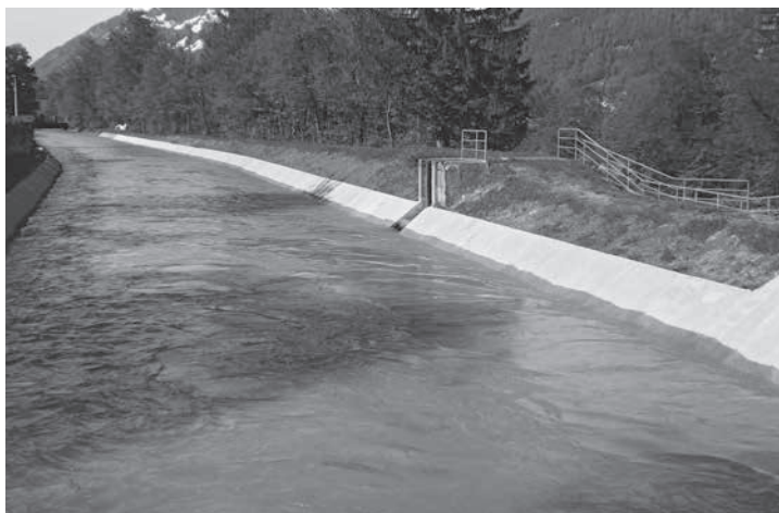
Die erste Etappe der Kanalsanierung ist erfolgreich vollendet worden. Sie wirkt sich dadurch aus, dass die Wassermassen schneller zur Turbine gelangen und damit der Wirkungsgrad um zirka zehn Prozent gesteigert werden kann. (Fotos: Hansjörg Spörri und Jakob Kubli)
