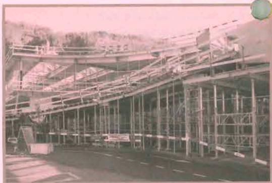
Die Schalung zur Erstellung der Auffahrrampe, im Hintergrund der schon fast fertig erstellte Wintergarten
