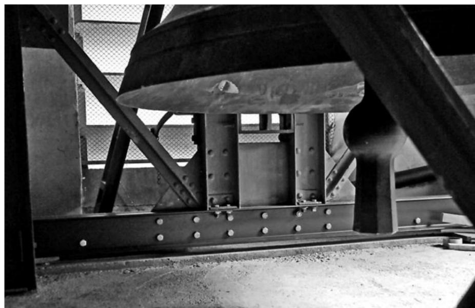
Der erneuerte, untere Teil des Glockenstuhls, der nun auf Gummi gelagert ist und auf dem neuen Zwischenboden steht.
