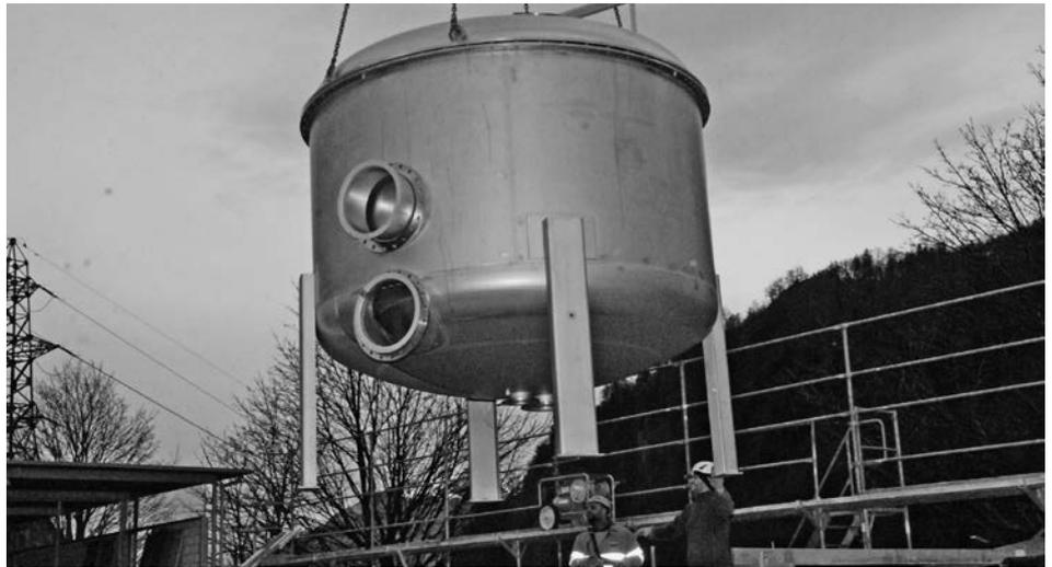
Mit dem neuen neue Druck-Anschwemmfilter wird das Badi-Wasser gereinigt. (Foto: Hans Speck)
