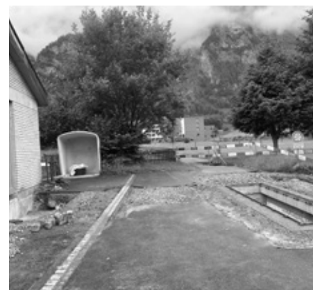
Die Baustelle bei der Kublihoschet. (Fotos: Archiv TBG)
