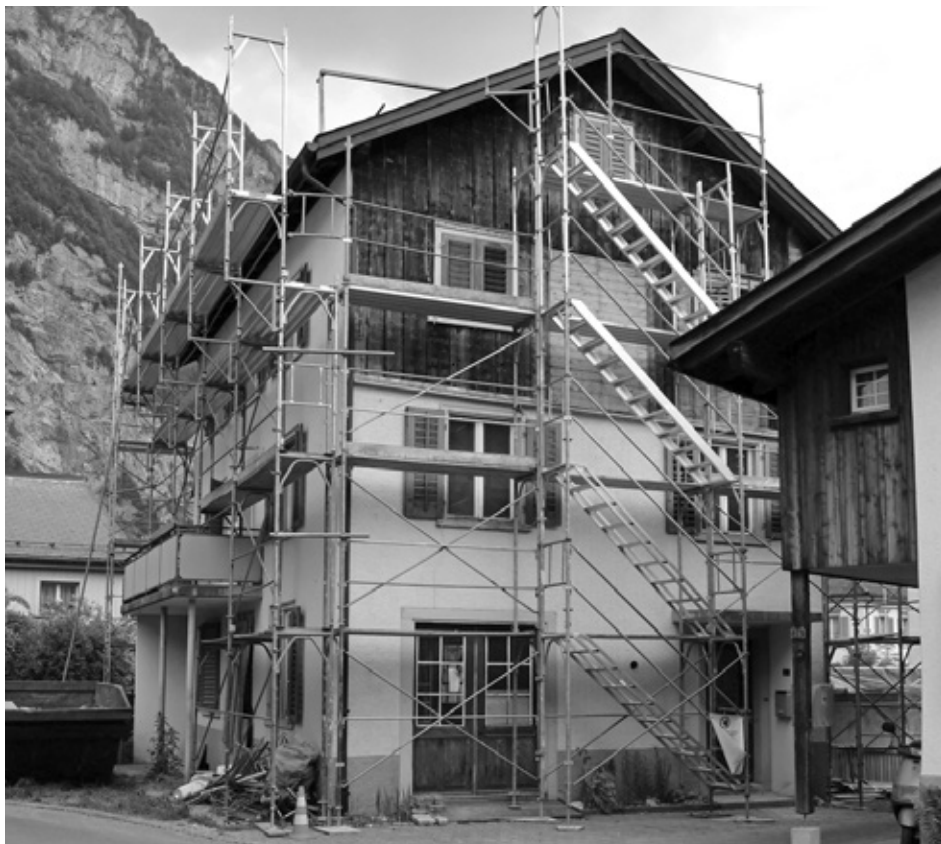
Das innen ausgehöhlte und aussen eingerüstete Haus von Wagner Kubli. (Foto: Christian Bosshard)
