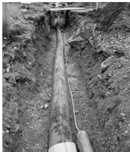
Auf dem Bild erkennt man die alten Kabel-Decksteine.
