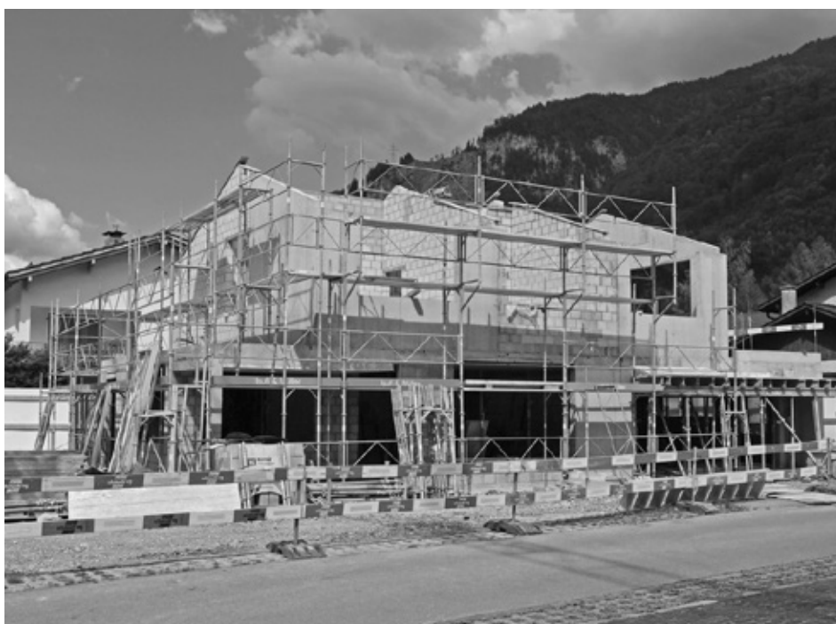
Der Rohbau des neuen Hauses am Höschetliweg. (Foto: Christian Bosshard)
