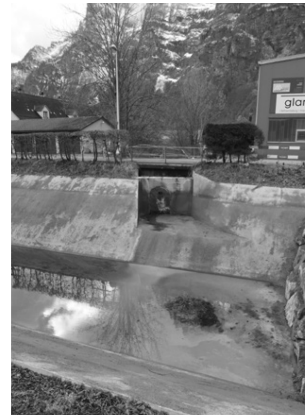
Der Zufluss des Dorfbaches wurde während der Sanierung in die Linth umgeleitet.
