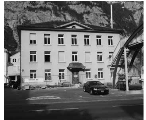
Der Haupteingang des alten Primarschulhauses wird geschlossen, um die Sicherheit vor dem Durchgangsverkehr zu erhöhen.
