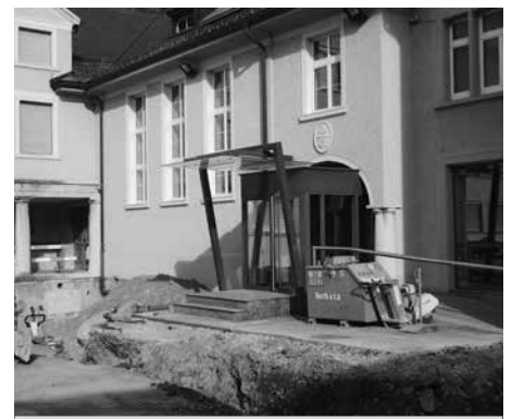
Der neue Eingang erfolgt nun über den Eingang der Mehrzweckhalle.
