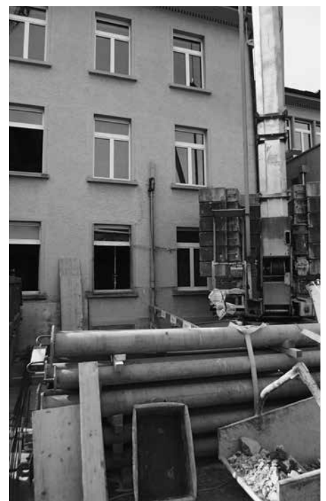
Baumaterialien vor dem ausgehöhlt Schulhaus. (Fotos: Jakob Kubli)
