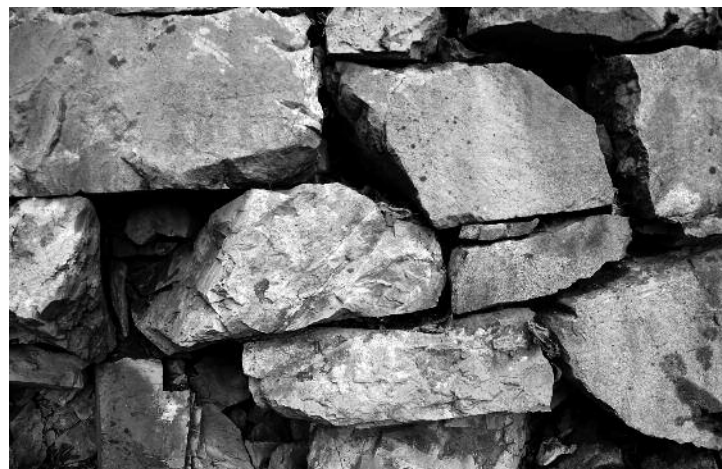
Gut erhaltene Trockenmauer auf der Ostseite des Burghügels.
