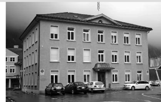
Das alte Schulhaus steht zur Zeit leer - soll aber in Zukunft wieder genutzt werden. (Foto: Jessica Loi)
