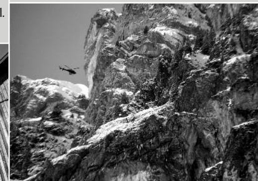
Begutachtung der Abbruchstelle.
