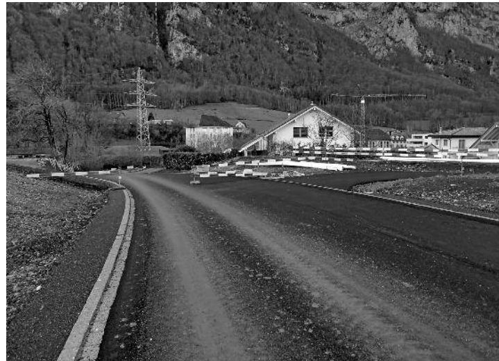
Die neue Zufahrt in die Wohnsiedlung Weid von der Lerchenstrasse her.
