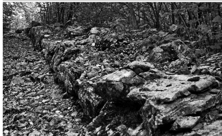
Trockenmauer auf der Ostseite der Bürglen, zum Teil mit Stauden und Moos überwuchert.
