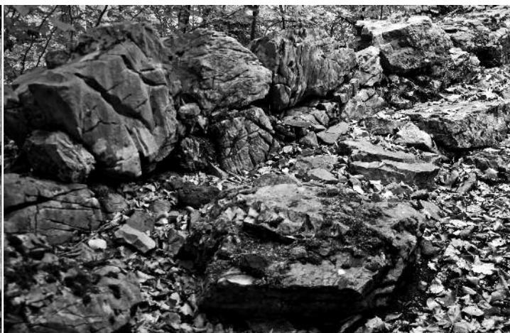
Mauerstruktur der Trockenmauer auf der Ostseite der Bürglen.
