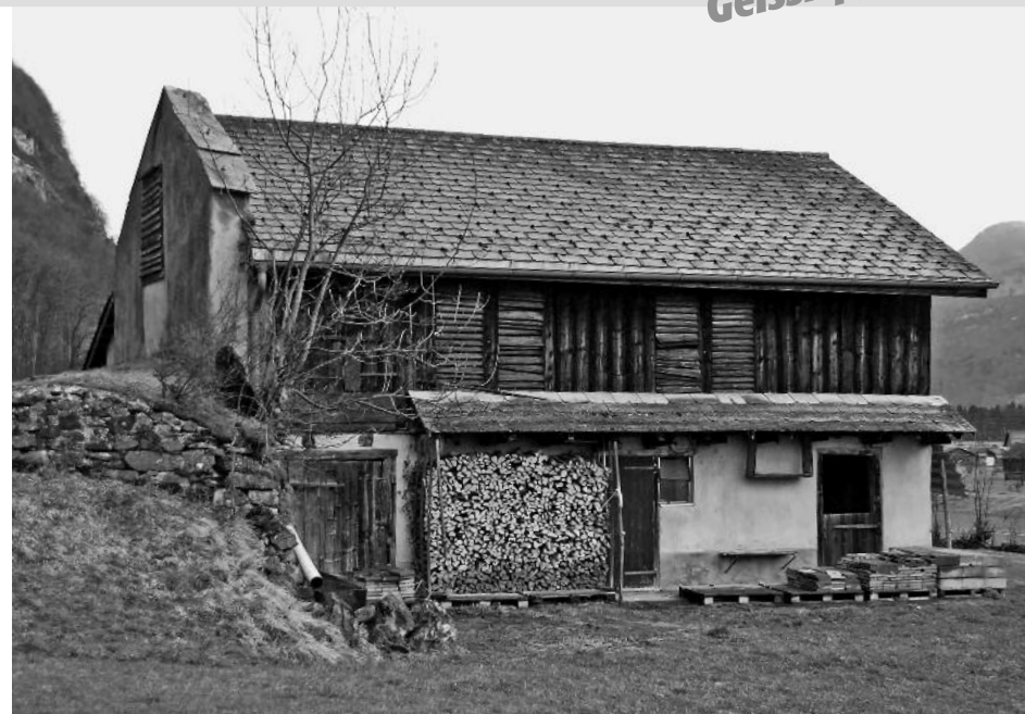
Der dem Abbruch geweihte Stall am «Altigerweg», befindet sich im «Aedi». (Foto: Jakob Heer)
