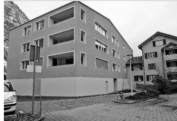
Anstelle des historischen Rain-Hauses hat die Ragotti + Weber Management AG einen wuchtigen Wohnblock mit neun Wohnungen gebaut. Rechts im Bild das wieder instand gestellte ehemalige Giesshaus.
