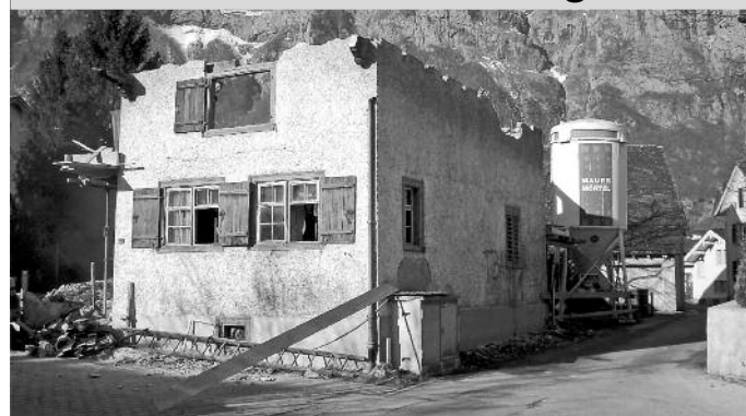
Das baufällige Haus beim Volksgärtli in Ennetbach wird ausgekernt und ausgebaut. (Foto: Jakob Kubli)
