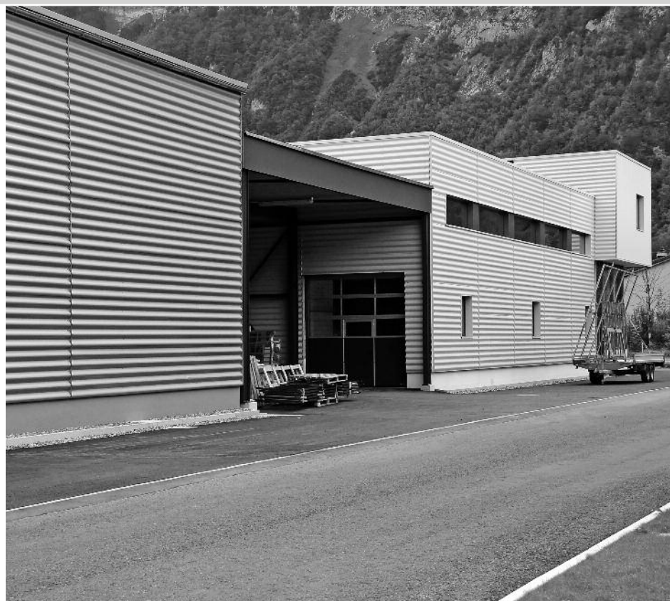
Nordseite mit dem neuen Anbau. (Foto: Christian Bosshard)
