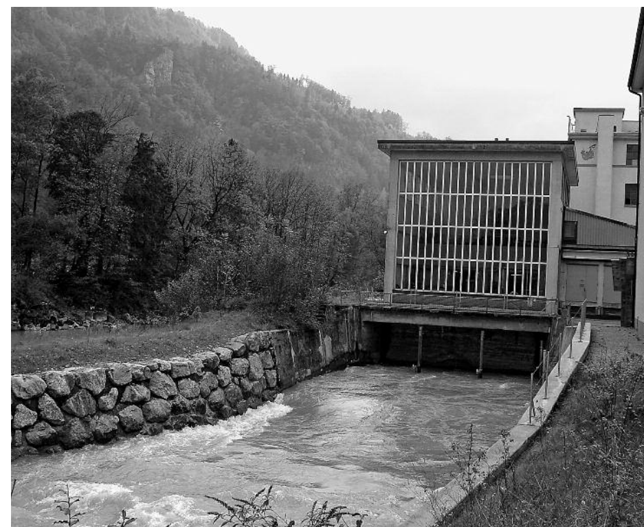
Das Turbinenhaus mit dem verstärkten Wuhr.
