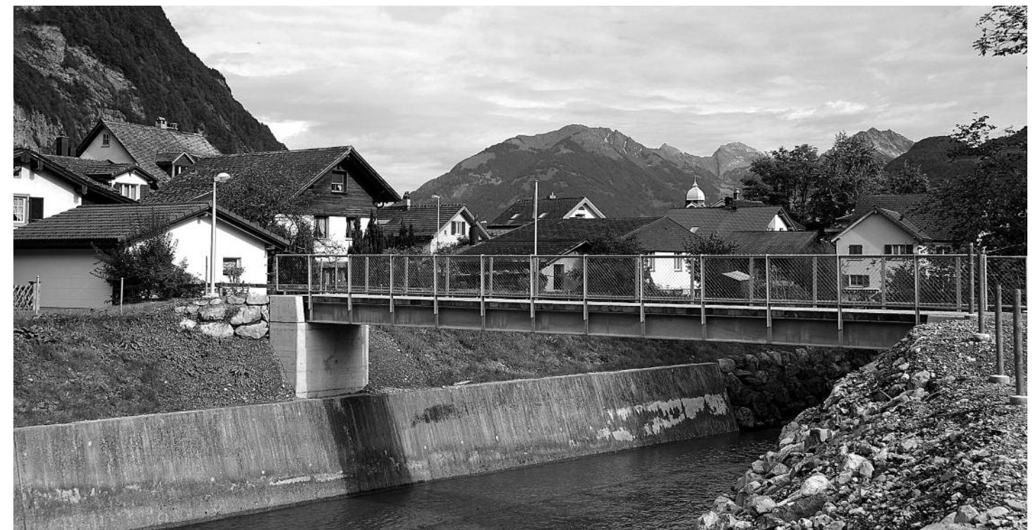
Der neue Fussweg samt Brücke vom Fuchsgut in die Risi wird von Schülern und Spaziergängern rege benutzt, (Foto: Hans Speck)
