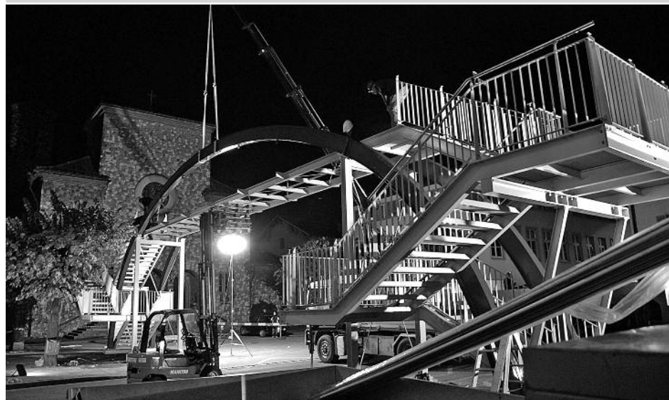
Aufbau der neuen Passerelle: Bereits ein erster Eindruck zeigt, dass da ein wahres Schmuckstück entsteht. (Fotos: Hans Speck)
