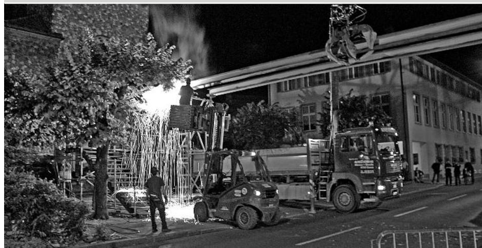
Pünktlich um 19.30 Uhr begannen die Abbrucharbeiten...
