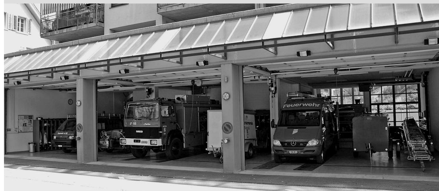
Die Feuerwehr Netstal wird mit einem Einsatzelement sicher bis 2013 bestehen bleiben. (Foto: Hans Speck)
