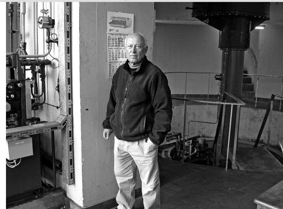
Projektleiter Hansjörg Spörri bei der vertikalen Kaplan-Turbine. (Fotos: Jakob Kubli)
