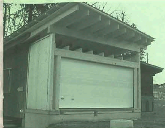
Von aussen sieht der Erweiterungsbau schon ziemlich fertig aus...
