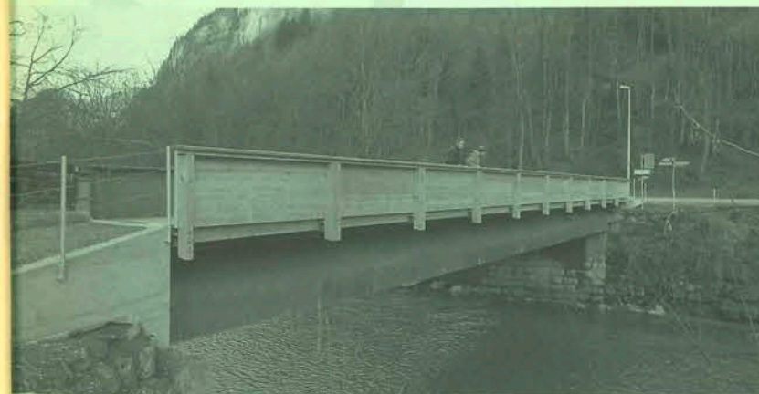
Der neue Fussgänger-Holzsteg auf der Südseite der Linthbrücke.
