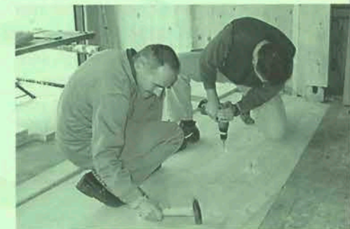
...während es innen noch viel Arbeit braucht. Hier zwei Mitglieder des Schützenvereins am Bohren und Hämmern.
