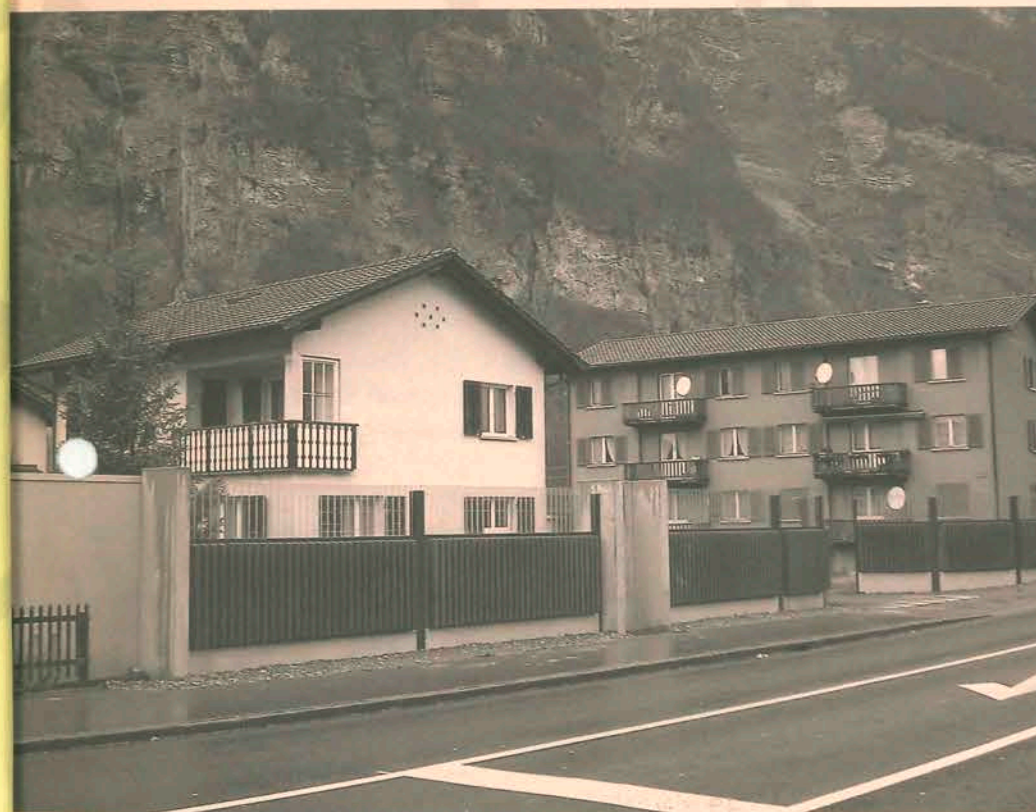
Die neue Lärmschutzwand im Klausen. (Foto: Jakob Kubli)
