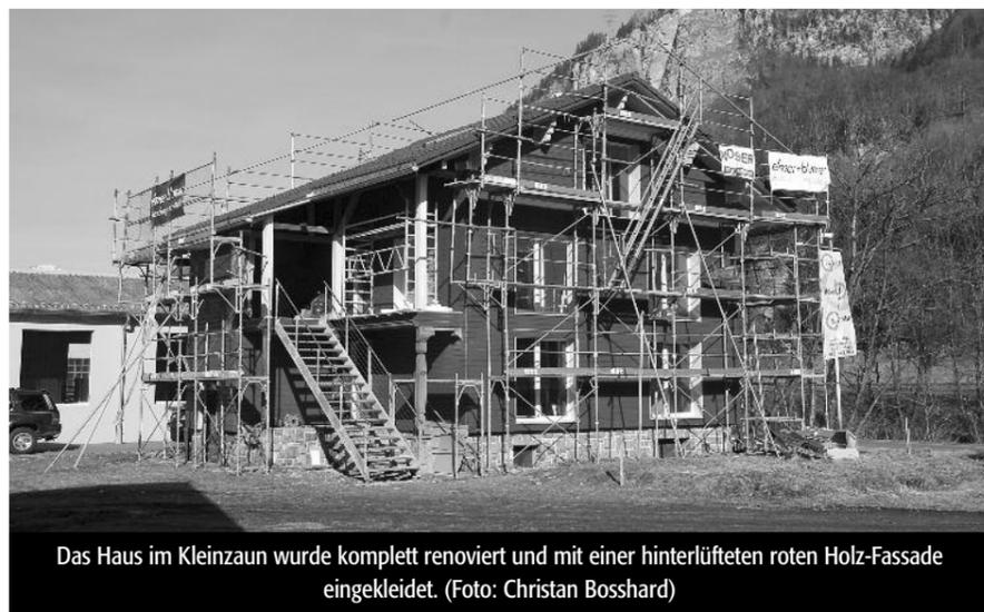
Das Haus im Kleinzaun wurde komplett renoviert und mit einer hinterlüfteten roten Holz-Fassade eingekleidet. (Foto: Christan Bosshard)
