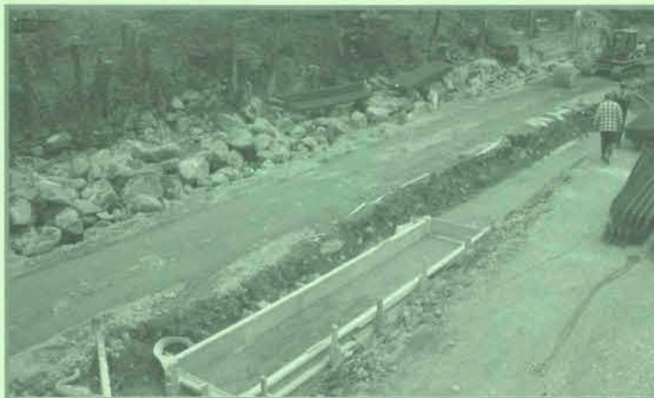
Das Betonieren des Kanales
